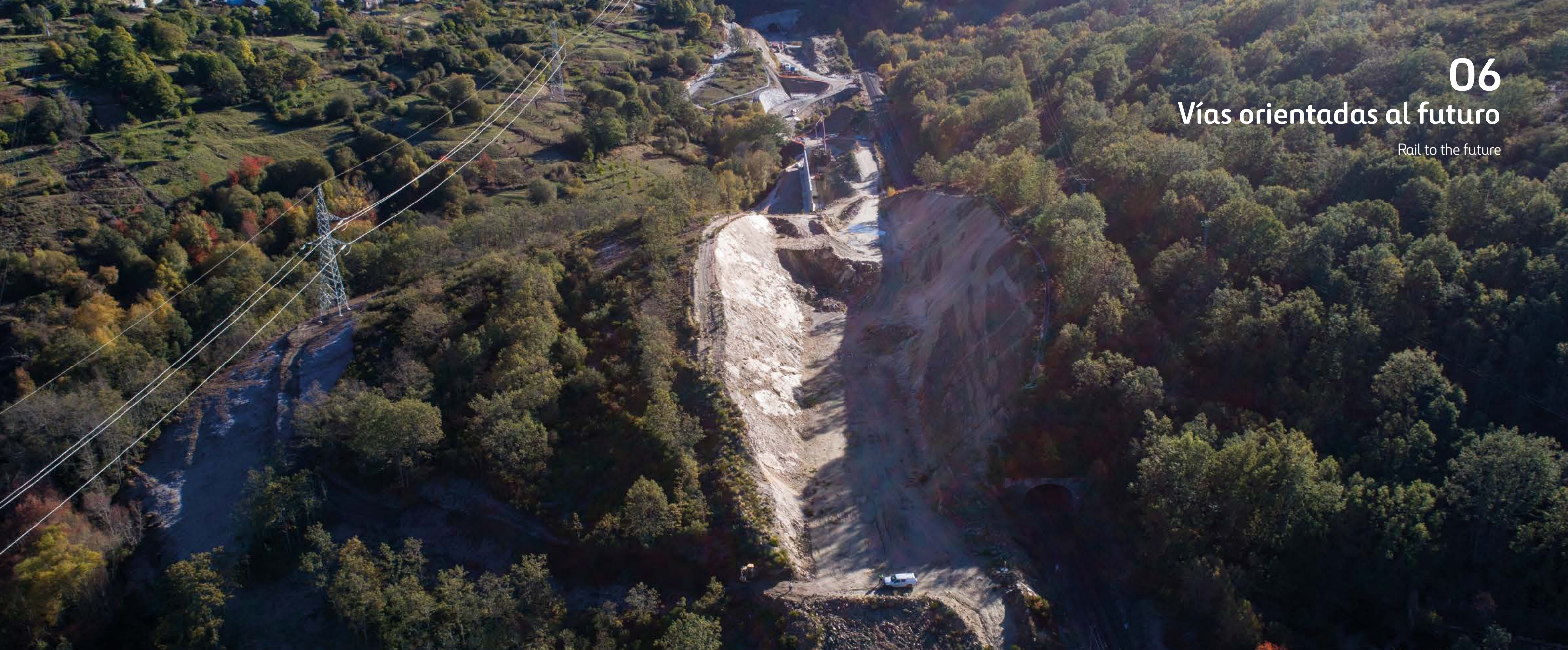
Obras de excavación del Túnel de Padornelo. AVE a Galicia. España.
