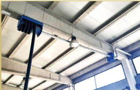
Cuando el motor de un vehículo debe estar al ralentí dentro de la zona del taller, en el tubo de escape del vehículo se instala una manguera para expulsar los gases salientes directamente al exterior. El almacén también está provisto de un sistema de ventilación forzada con temporizador para garantizar que la calidad del aire en la zona de trabajo sea la adecuada.
