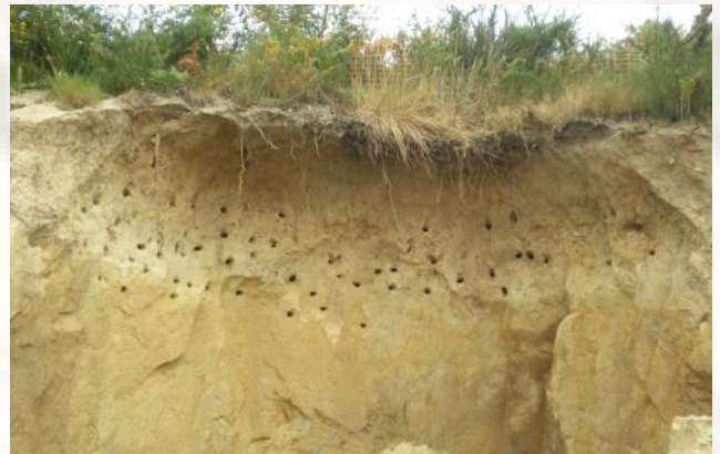
Colonia de avión zapador en desmonte de la obra AVE Rialño- Padrón
