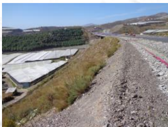
Taludes restaurados con vegetación autóctona
