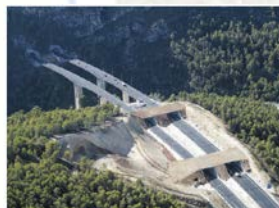
Vista del tramo en el que se implanta la estructura de protección del paso de murciélagos
