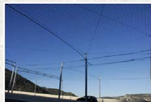
Detalle de la estructura de protección del paso de murciélagos
